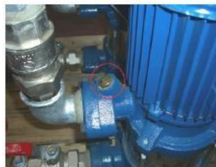
Obrázek 7: Montáž čidla na odvzdušňovací otvor výtlaku čerpadla
